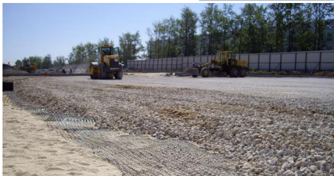
Устройство проездов и площадок при строительстве завода Роллтон в Московской области
