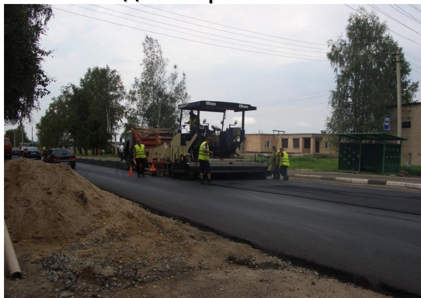
Укладка асфальтобетона
