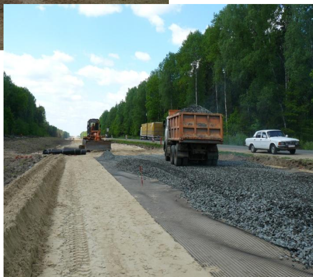
Реконструкция автомобильной дороги Минск-Могилев км 84,5- км 89,0 в Республике Беларусь
