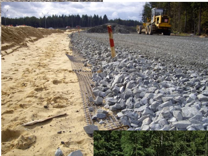
Строительство развязки на М-1 (33км) Московская область
