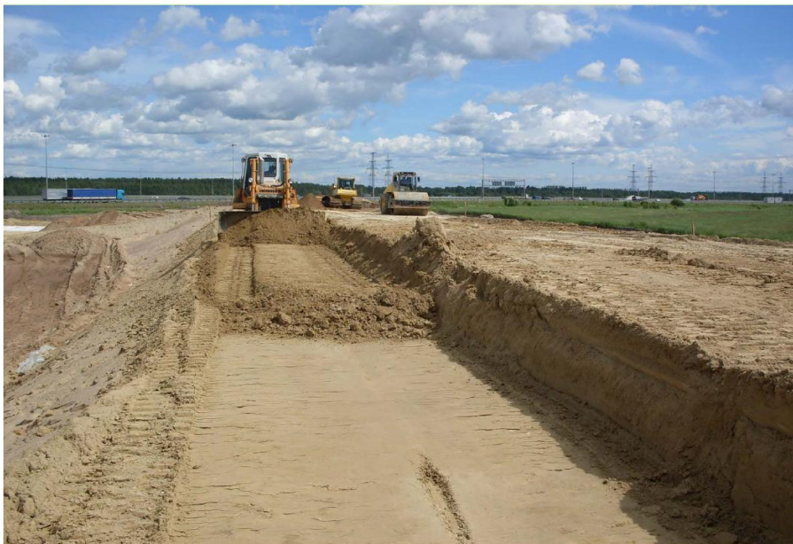
Анкерование георешетки или геотекстиля
