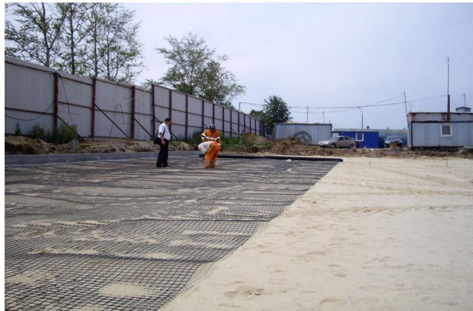
Анкерование георешетки или геотекстиля
